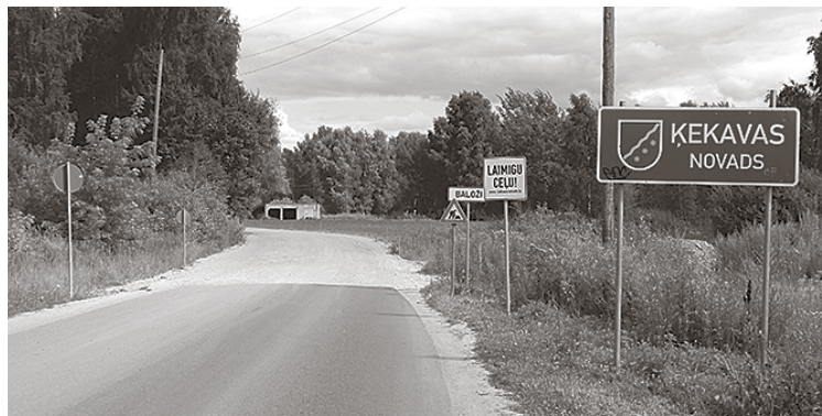
Ceļa posms Medemciems–Baloži drīzumā sagaidīs rekonstrukciju.
